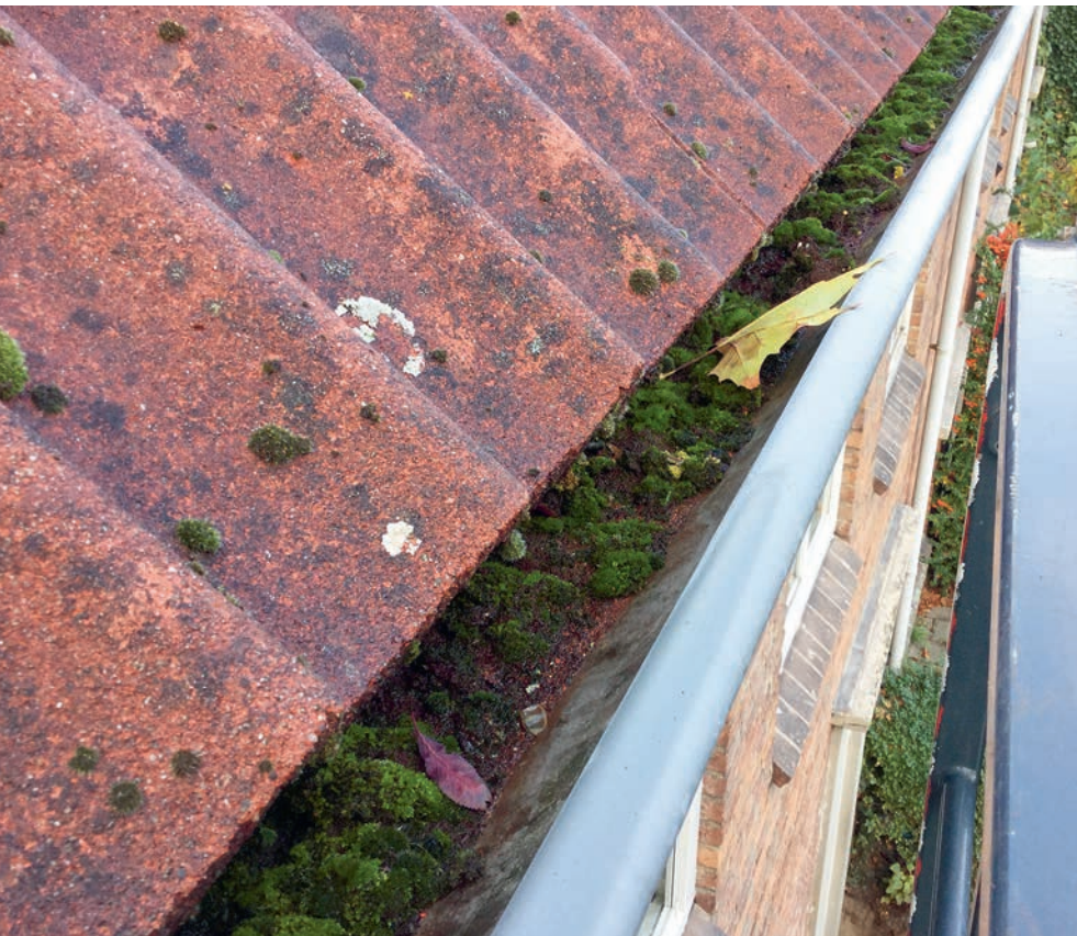
Juist door vervuiling blijft water langer achter in de goot, in plaats van zijn weg te zoeken naar de hemelwaterafvoer.
