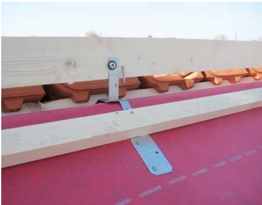
Plaatsen van een ruitersleun met verkeerde schroeven in de ruitersleun en gespleerd in plaats van geschroefd op de constructie.
