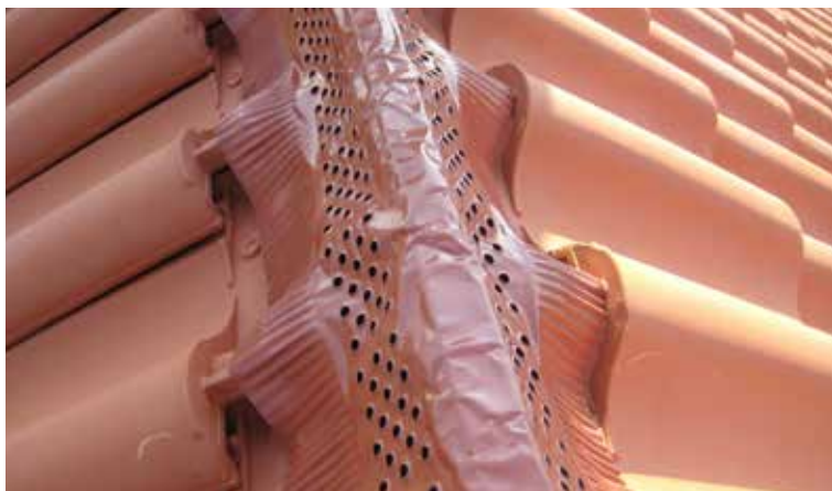
Dakpannen niet hoog genoeg tegen de ruitersleun. Ondervorst is te kort.
