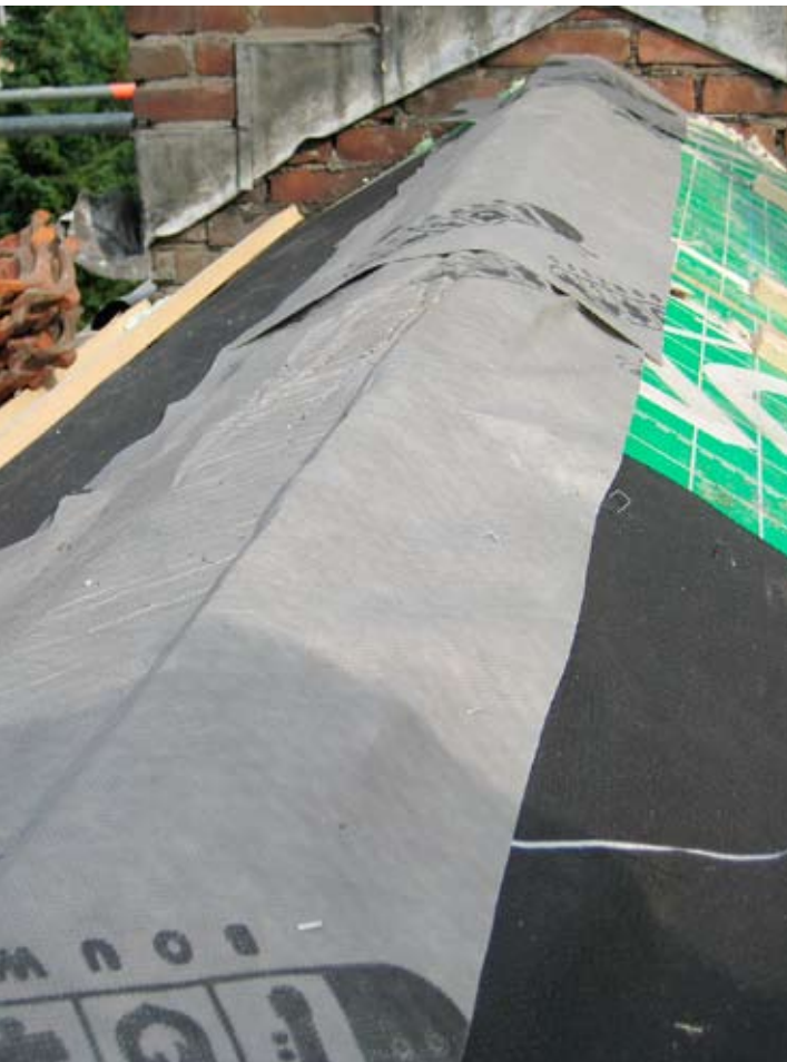
Praktijkvoorbeeld en principedetail van de isolatie van een nok met een geprefabriceerde 'nokrups'.
