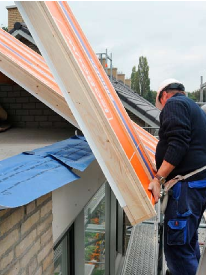
Praktijkvoorbeeld en principedetail van de isolatie van een dakvoet met een geprefabriceerde 'dakvoetruis'.
