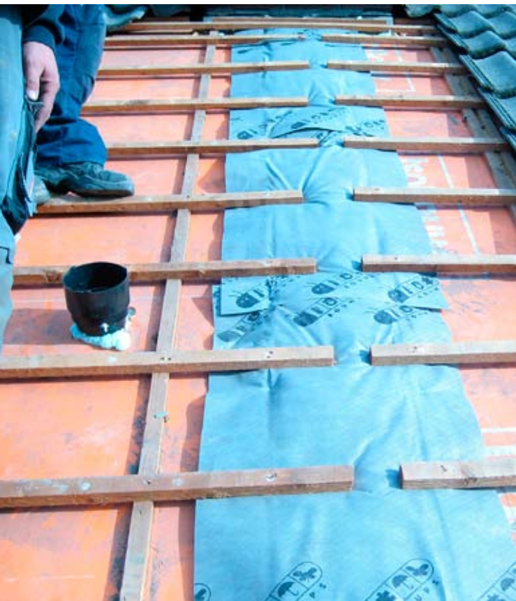
Praktijkvoorbeeld en principedetail van de isolatie van een woningscheidende wand met een geprefabriceerde 'gevelrups'.
